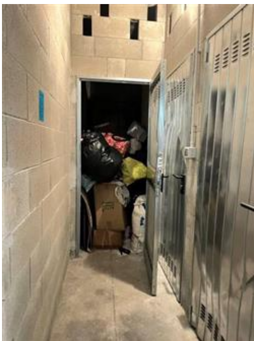
LOCALE CANTINA AL PIANO TERRENO
