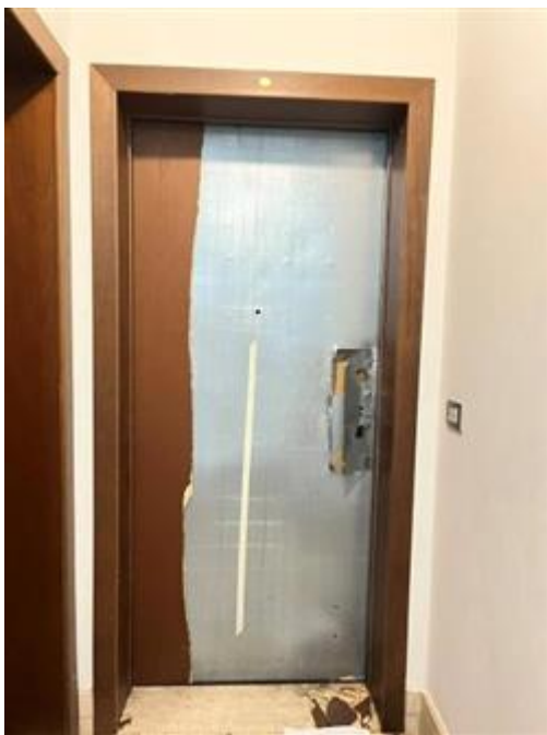
PORTA DI INGRESSO ALLOGGIO (dopo accesso forzoso)
