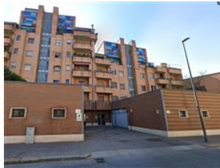
VISTA DA VIA PIANEZZA
